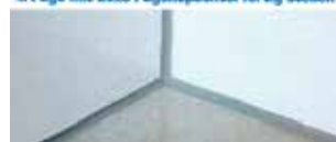
4. Fuge mit beko Fugenspachtel fertig stellen
