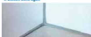
1. Silicon auftragen
