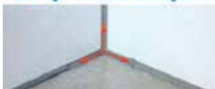
3. beko Fugenschnur in alle Richtungen ziehen
